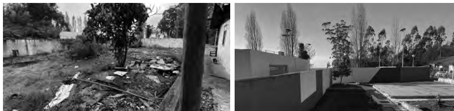
Figura 82 e 83: Antes e depois da limpeza do espaço da antiga casa 5 Fonte: L3P/UA
