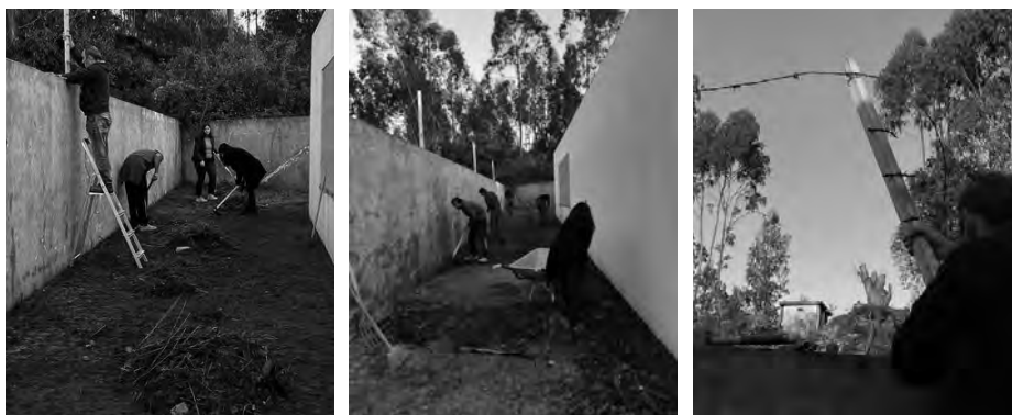
Figuras 95, 96 e 97: Limpeza dos silvados na envolvente e retirada de arame farpado Fonte: L3P/UA
